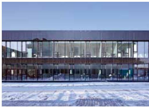
54 Nestlé, Bâtiment E
