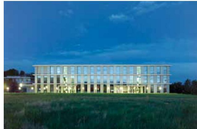
56 Biopôle, Bâtiment B3
