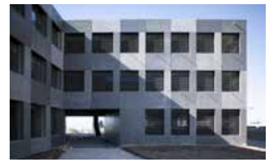
52 Biopôle, Bâtiment B4
